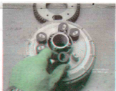
Installation des nouveaux silent-bloc
